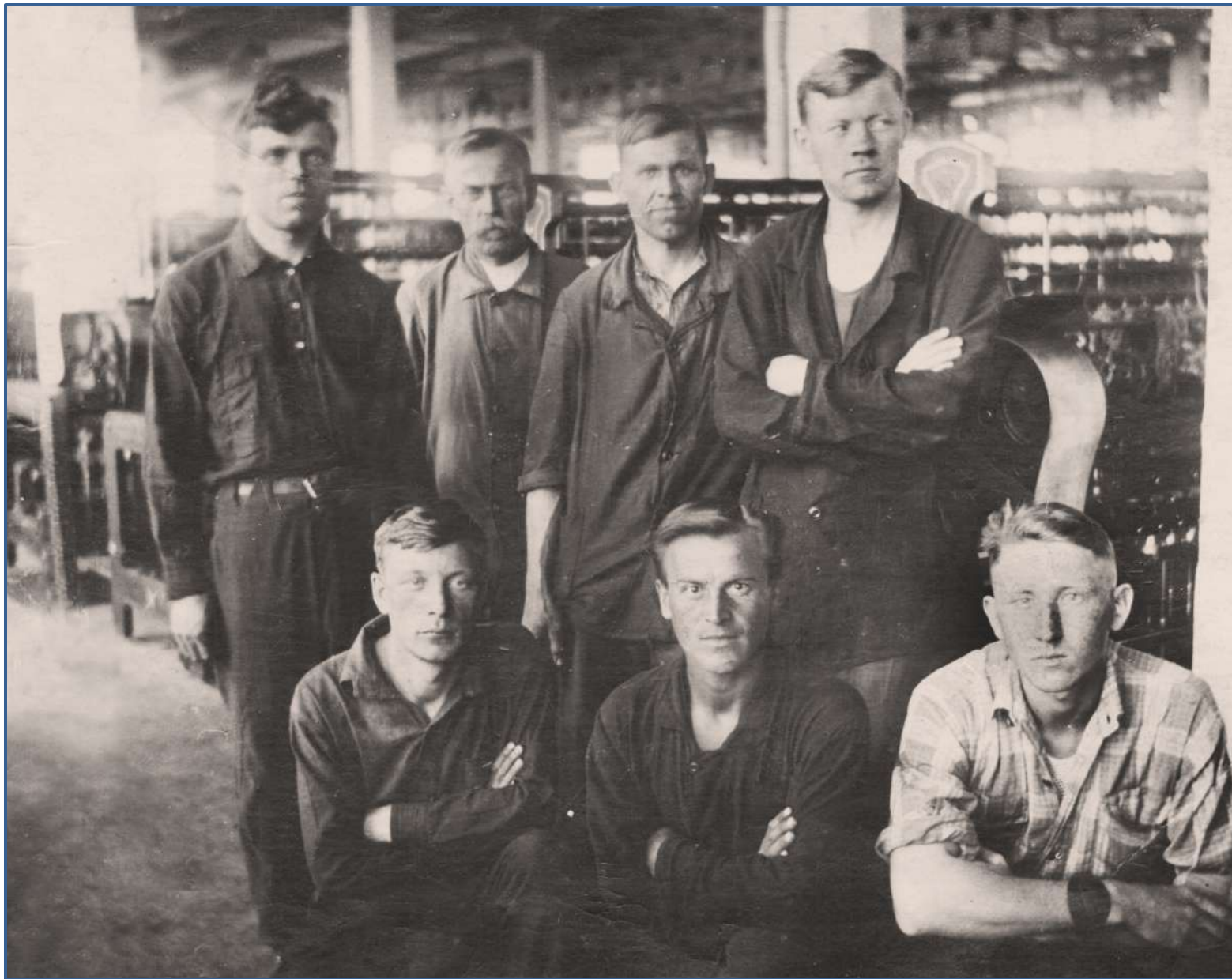
1925 ГОД. БРИГАДА ПО РЕМОНТУ ЭЛЕКТРООБОРУДОВАНИЯ.
