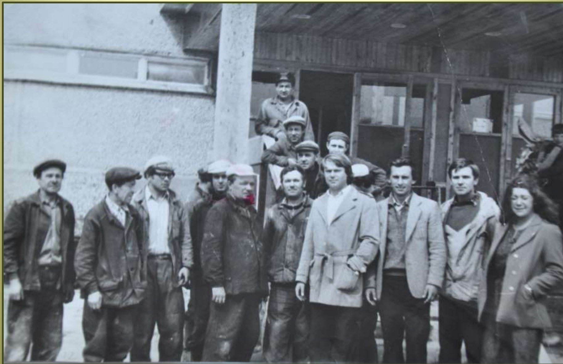
Строители нового здания школы № 6 города Реутова.
